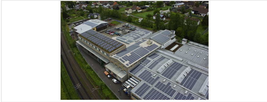
Auf den Dächern der AKO Kunststoffe Alfred Kolb GmbH ist eine PV-Anlage installiert. Bild: Andreas Janthur
